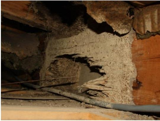
イエシロアリの被害にあった中天井（1階と2階のあいだの空間）の木材。イエシロアリの被害はとにかく激烈で広範囲に及ぶのが特徴。
